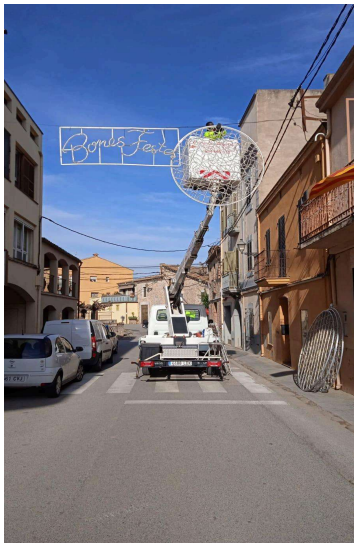
Imatge 3. Treball instal·lacions elèctriques, enllumenat Nadal.
