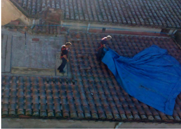
Imatge 1. Treballs de manteniment.
