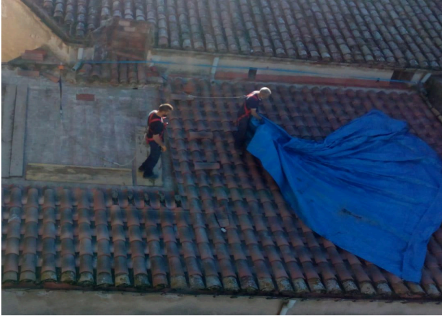
Imatge 1. Treballs de manteniment.
