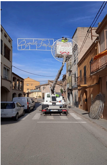
Imatge 3. Treball instal·lacions elèctriques, enllumenat Nadal.
