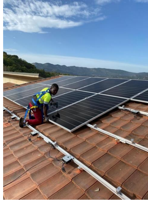
Imatge 4. Treballs instal·lacions elèctriques.
