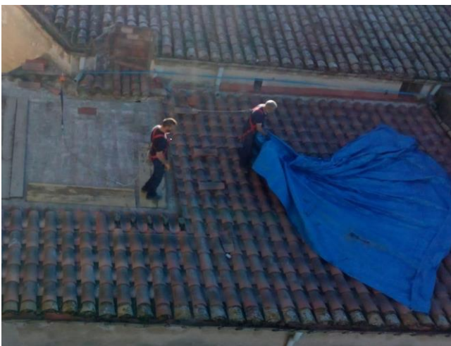
Imatge 1. Treballs de manteniment.
