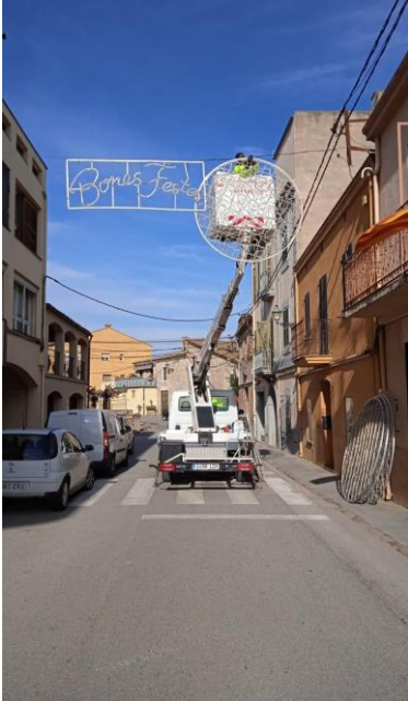
Imatge 3. Treball instal·lacions elèctriques, enllumenat Nadal.
